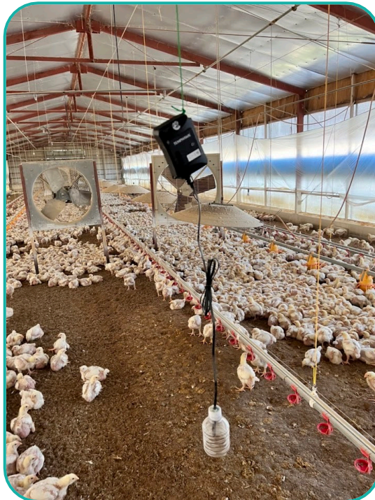
鶏舎での設置例 ミストなどの水分がセンサー部に付着し気化熱で温度が下がらないようにプラスチック素材でカバー
